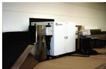
Figure 15 : Appareils de radioscopie VIS et VDS. L'appareil VIS108 est illustré à gauche alors que l'appareil VDS108 utilisé pour l'enregistrement des bagages surdimensionnés est illustré à droite.
